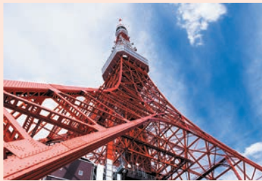
直下から見上げる東京タワーは迫力満点です！ 当代きっての巨大建造物であることを実感できます。特徴的なトラス構造にも注目してくださいね。
